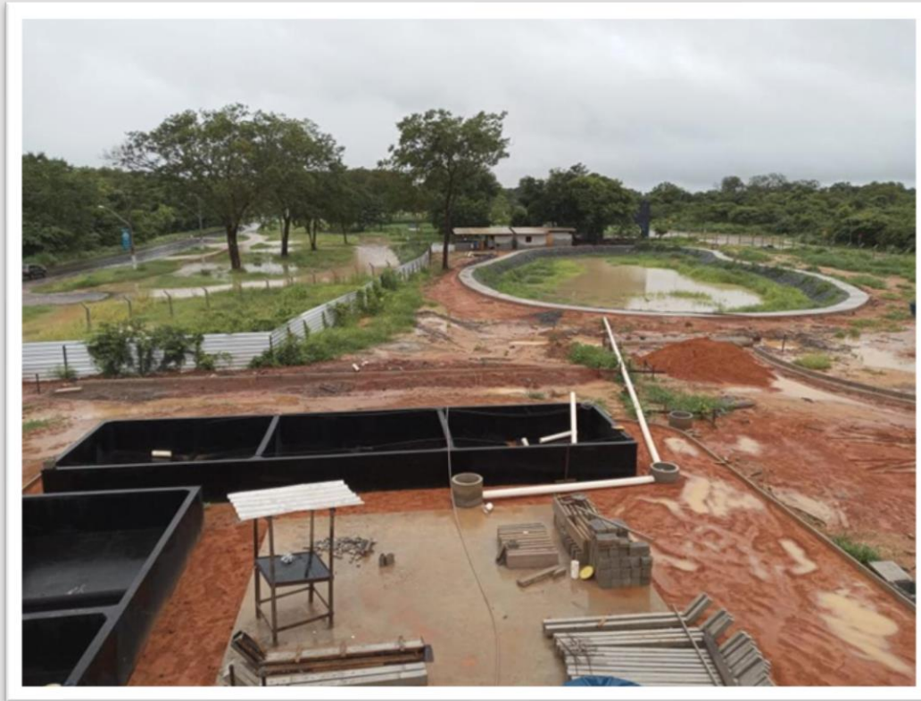
Lagoa de efluente tratado e leitos de secagem - em execução.
