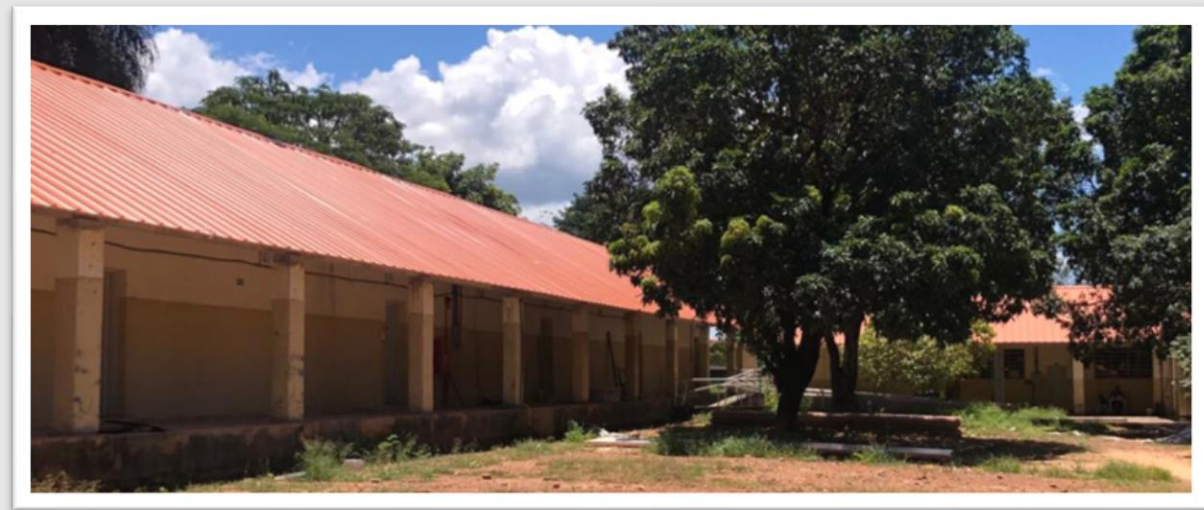
Pavilhões 03 e 07 (Etapa I) - em execução
