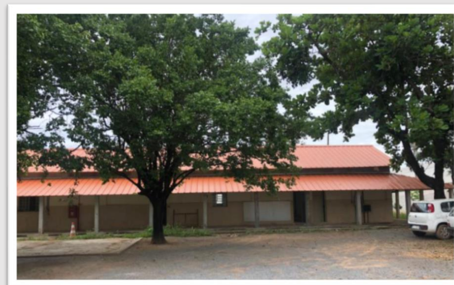
Instalação de telhas nos prédios da Reitoria. Oferecem maior conforto térmico, visando a redução de consumo de energia elétrica.
