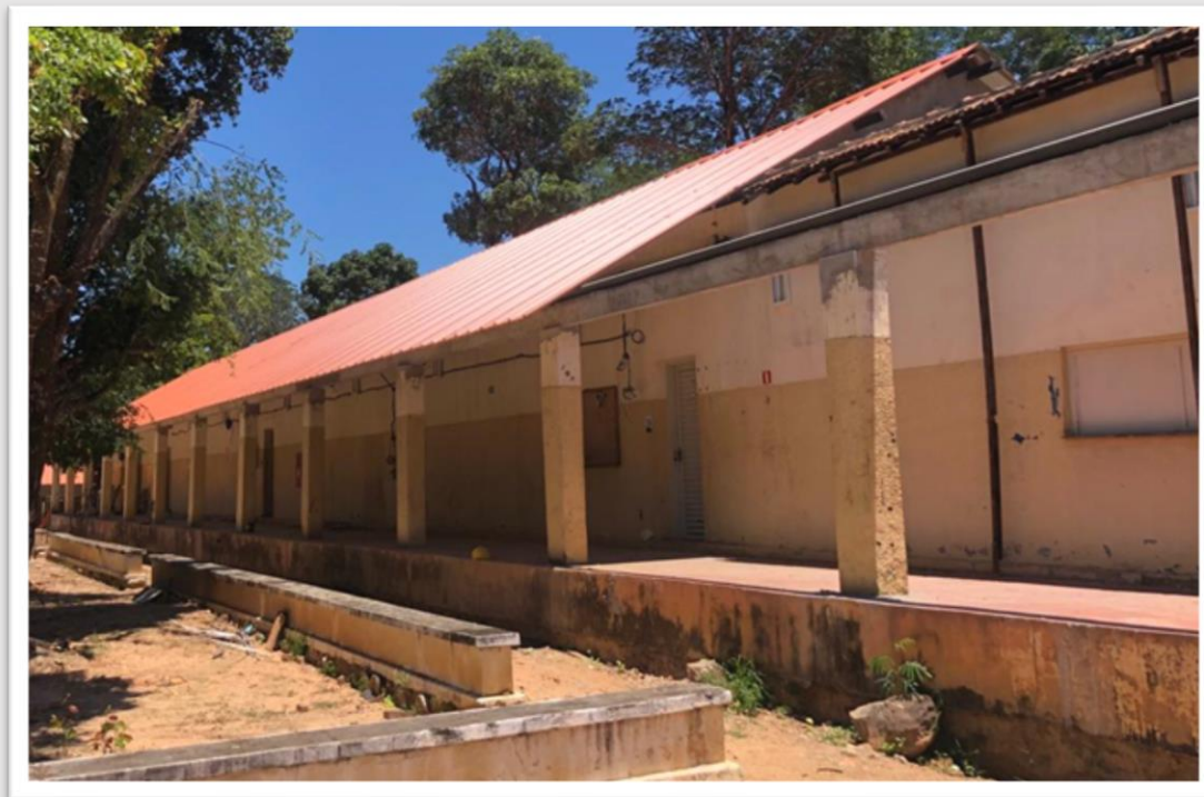
Pavilhões 04 (Etapa I) - em execução
