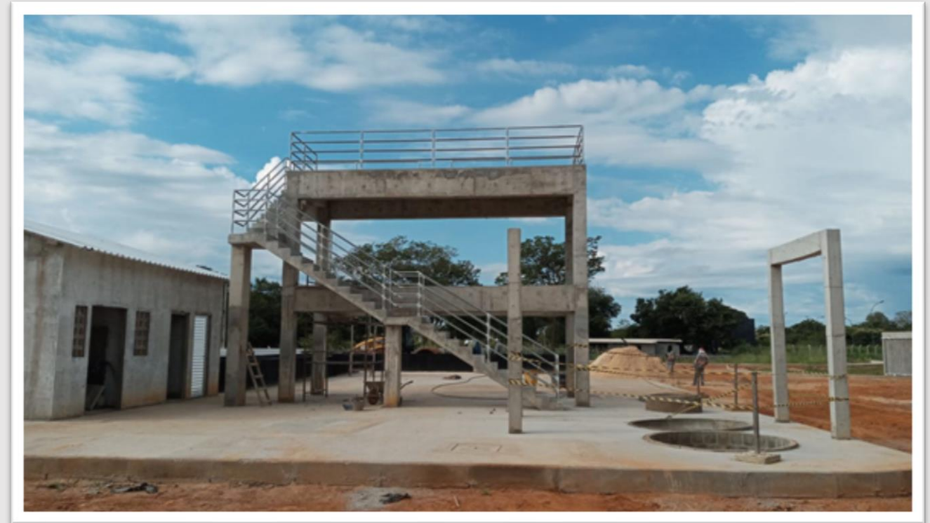
Base elevada e casa de operação - em execução
