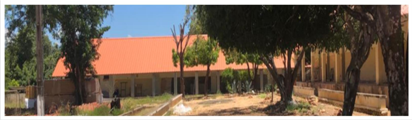
Pavilhão 05 (Etapa I)- em execução.
